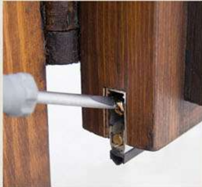
Detalle de regulación del burlete Detail of the adjustment of the weatherstrip تفصيل تنظيم الكوتشوك
